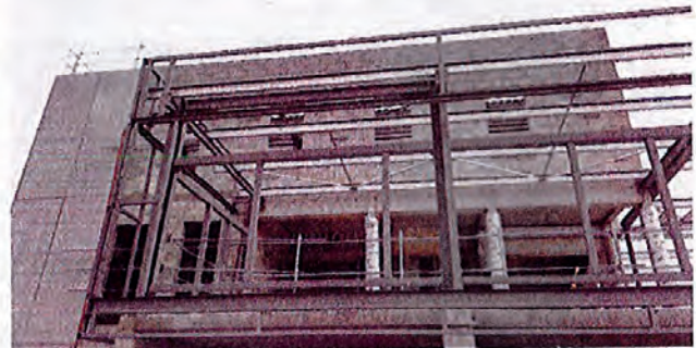
Le nouveau bâtiment occulte l'ancienne façade art déco
